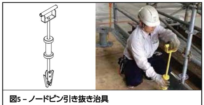
図5 - ノードピン引き抜き治具
